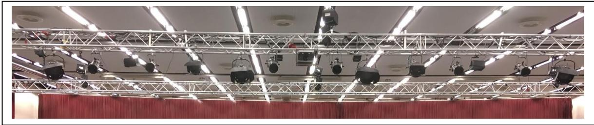
Die 1. Saal-Traverse ist fest verdrahtet. In diesem Zug befinden sich 2 x 6 Versätze á 2 kW, Direktstrom 2 x 16A CEE + 1 x 16A Schuko (Beamer), 1 x freie DMX Leitung über hauseigenen Splitter. Bestückt ist dieser Zug standardmäßig mit 6 x Arri 2 KW Stufenlinsen + 6 x ETC Source Four Profilern.
